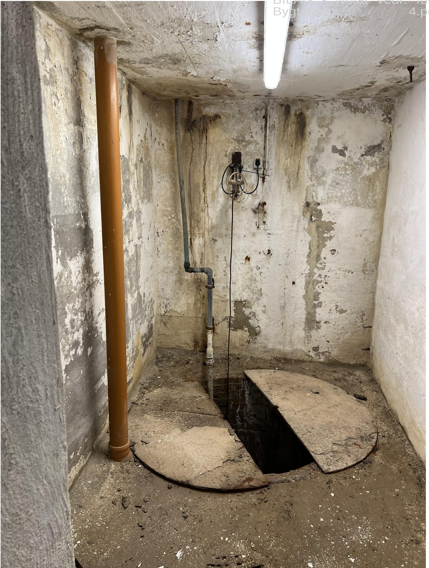
Kælderdel som ligger ud under terræn.
